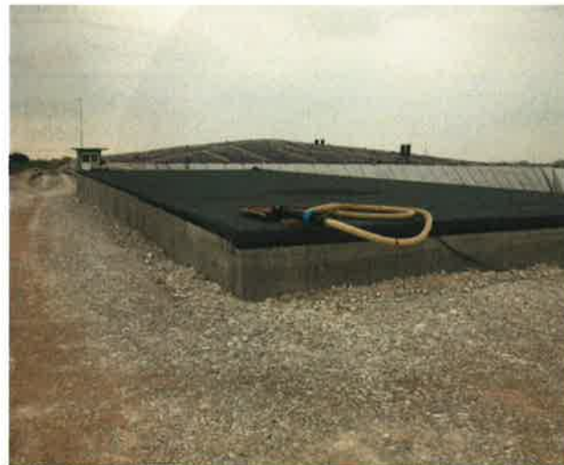
Fig.8 - Vasca raccolta percolato quarto lotto
