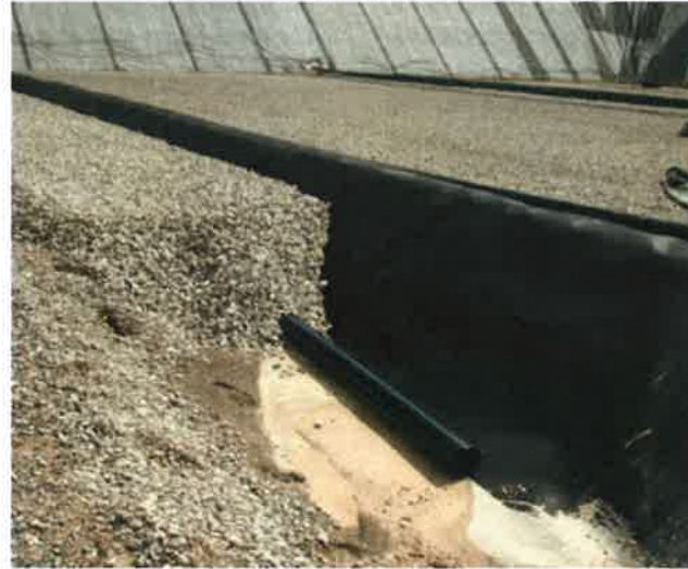
Fig.7 - Tubazione drenaggio percolato
