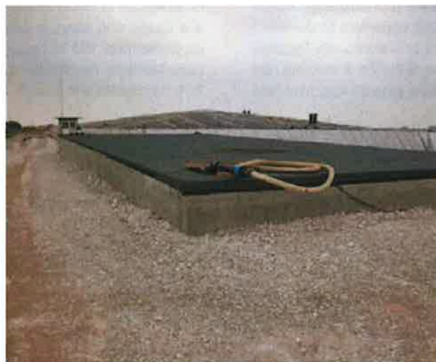
Fig.8 - Vasca raccolta percolato quarto lotto
