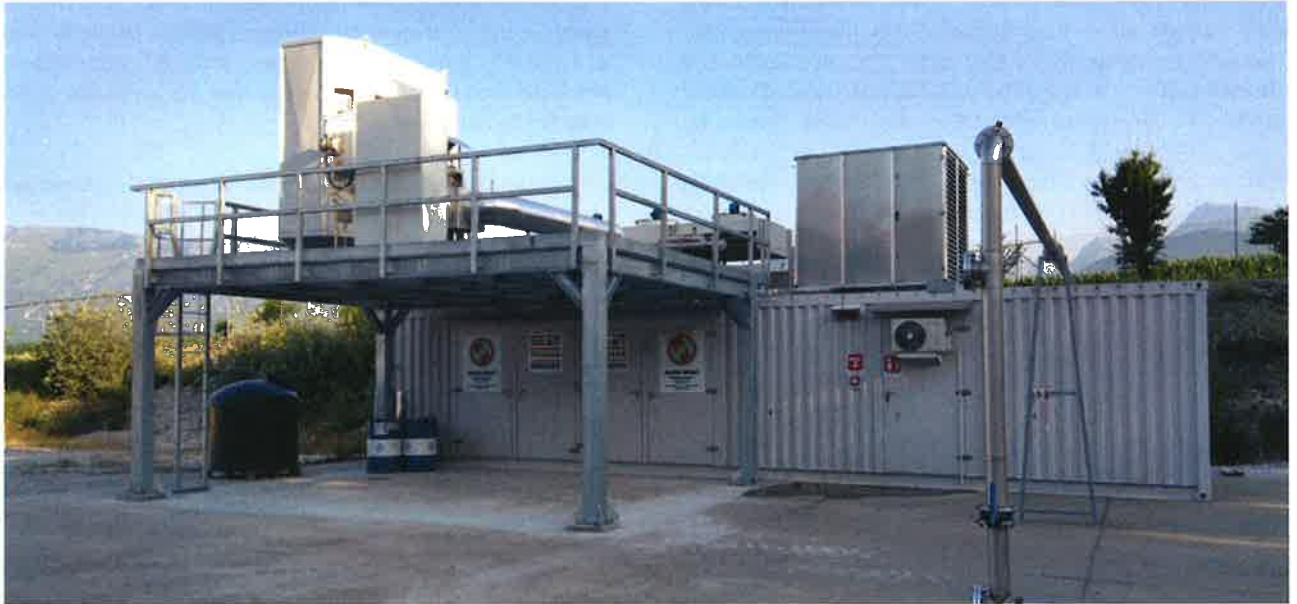
Fig.9 - Impianto di cogenerazione a biogas
